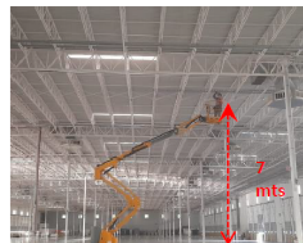
7m de altura al hombro y 8m a la Cumbrera
