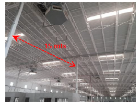
15 mts de claro entre columna y columna
